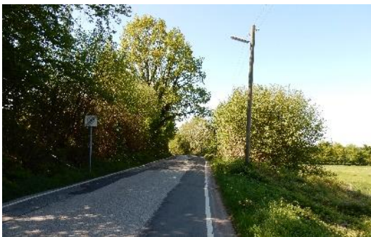
Abbildung 38: Fehlende Fußwegeverbindung von Rönne nach Wellsee
