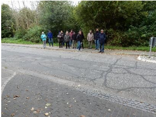
Abbildung 44: Einmündung in den Pfaffensteig und baulich angelegte Fahrbahneinengung
