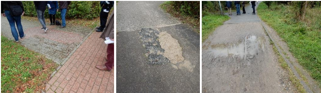
Abbildung 29: Stolperkanten und Löcher in der Oberfläche des Paul-Pfiel-Wegs
