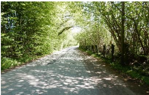
Abbildung 26: Unbefestigter Seitenbereich der Fahrbahn dient aktuell als „Fußweg“
