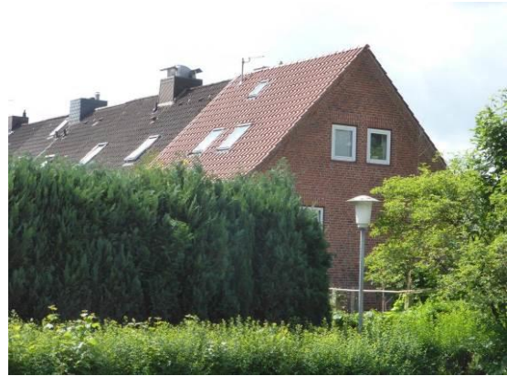
Abbildung 29: Ortsgang/ Giebel ausgeführt mit Tondachpfannen in Mörtelbett
