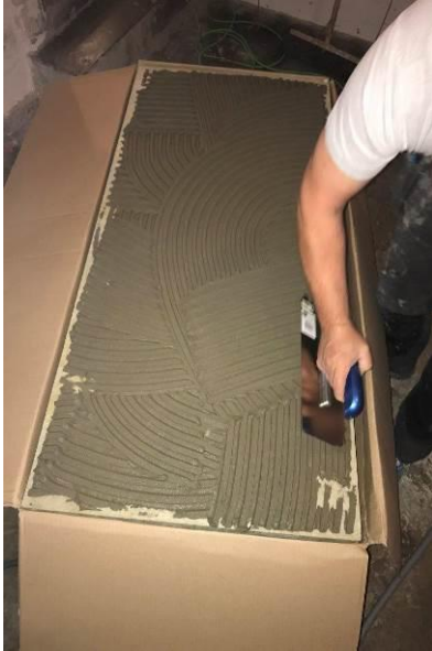
Abbildung 35: Vorbereitungsarbeiten zur Montage der Dämmplatten
