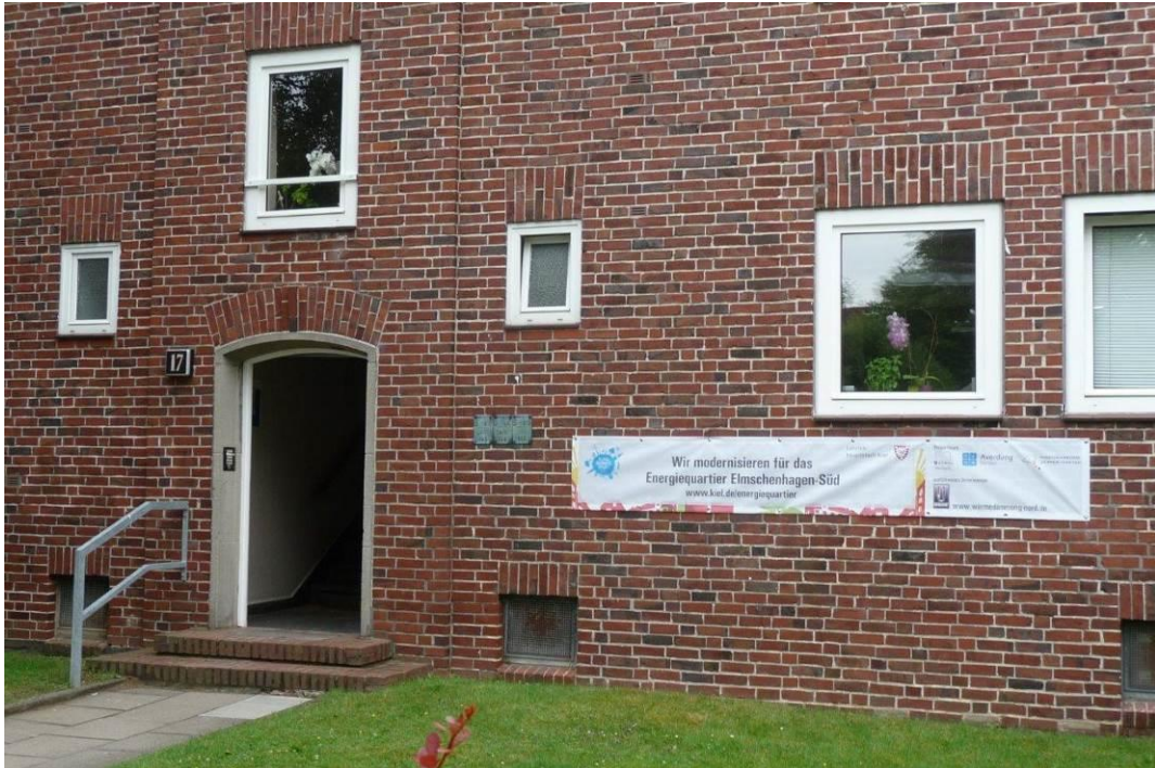
Abbildung 26: Vorbereitungsarbeiten zur Aufnahme der Innendämmung
