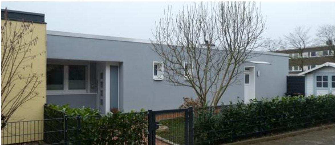
Abbildung 42: Ansicht nach der Sanierung
