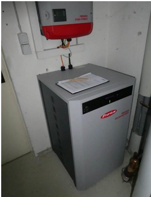
Abbildung 23: Stromspeicher 7,5 kw/h
