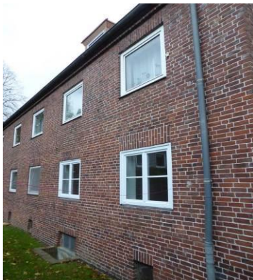
Abbildung 20: Erhaltenswerte Backsteinfassade mit neuen, geteilten Fenstern (unten
