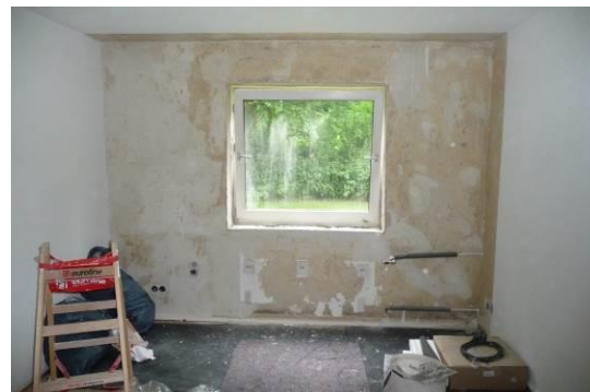
Abbildung 28: Vorbereitungsarbeiten für die Innendämmung
