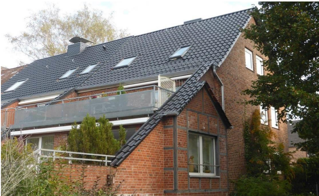
Abbildung 34: Fertiggestelltes Dach mit anthrazitfarbenen Tondachpfannen
