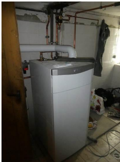
Abbildung 38: Neuer, effizienter Brennwertkessel
