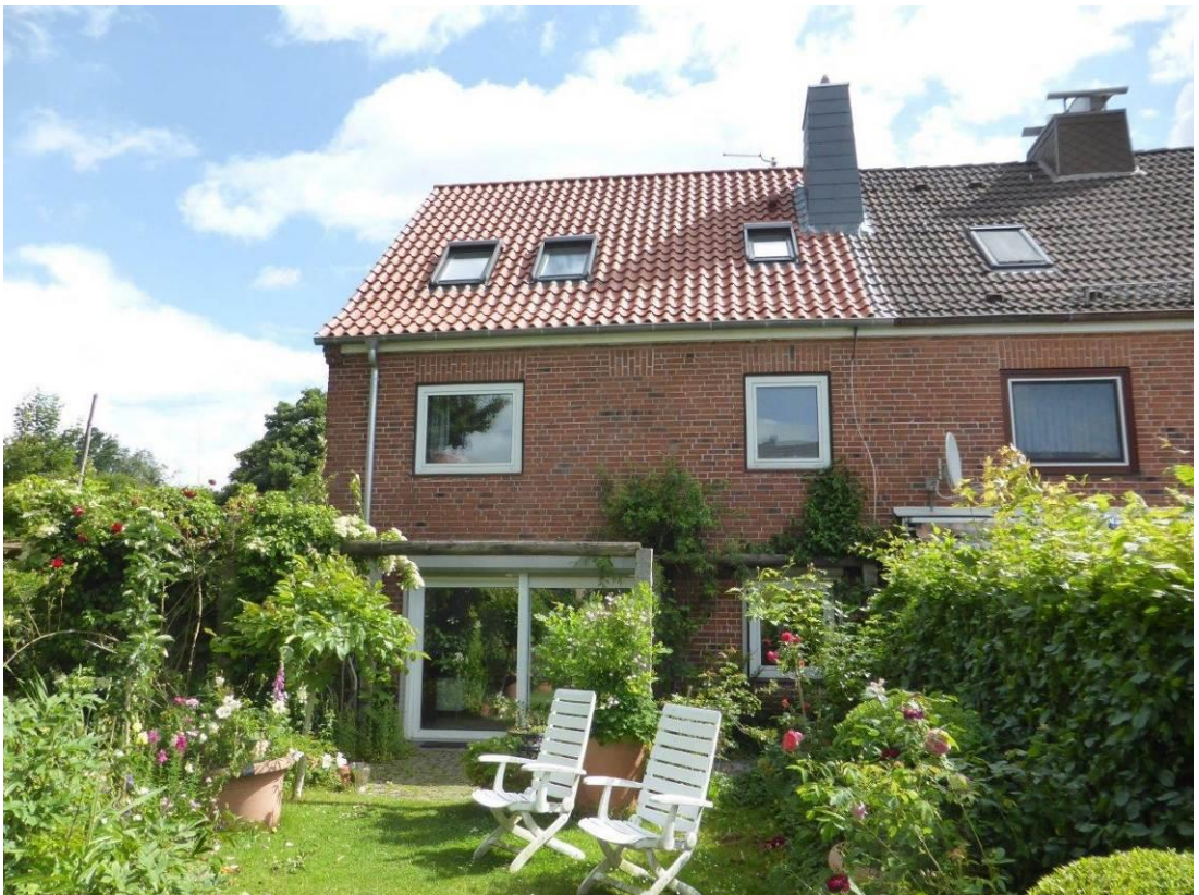
Abbildung 31: Neue Tondachpfannen neben Betondachpfannen
