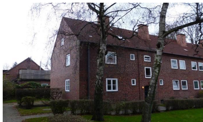
Abbildung 20: Erhaltenswerte Backsteinfassade mit neuen, geteilten Fenstern (unten
