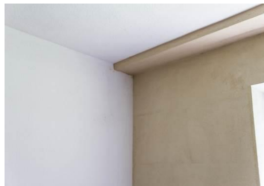
Abbildung 48: Noch nicht vollständig verputzte Innendämmung
