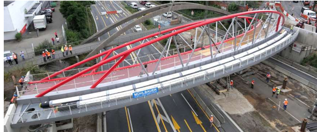
Eisenbahnbrücke in Hamburg: leichte horizontale Krümmung
