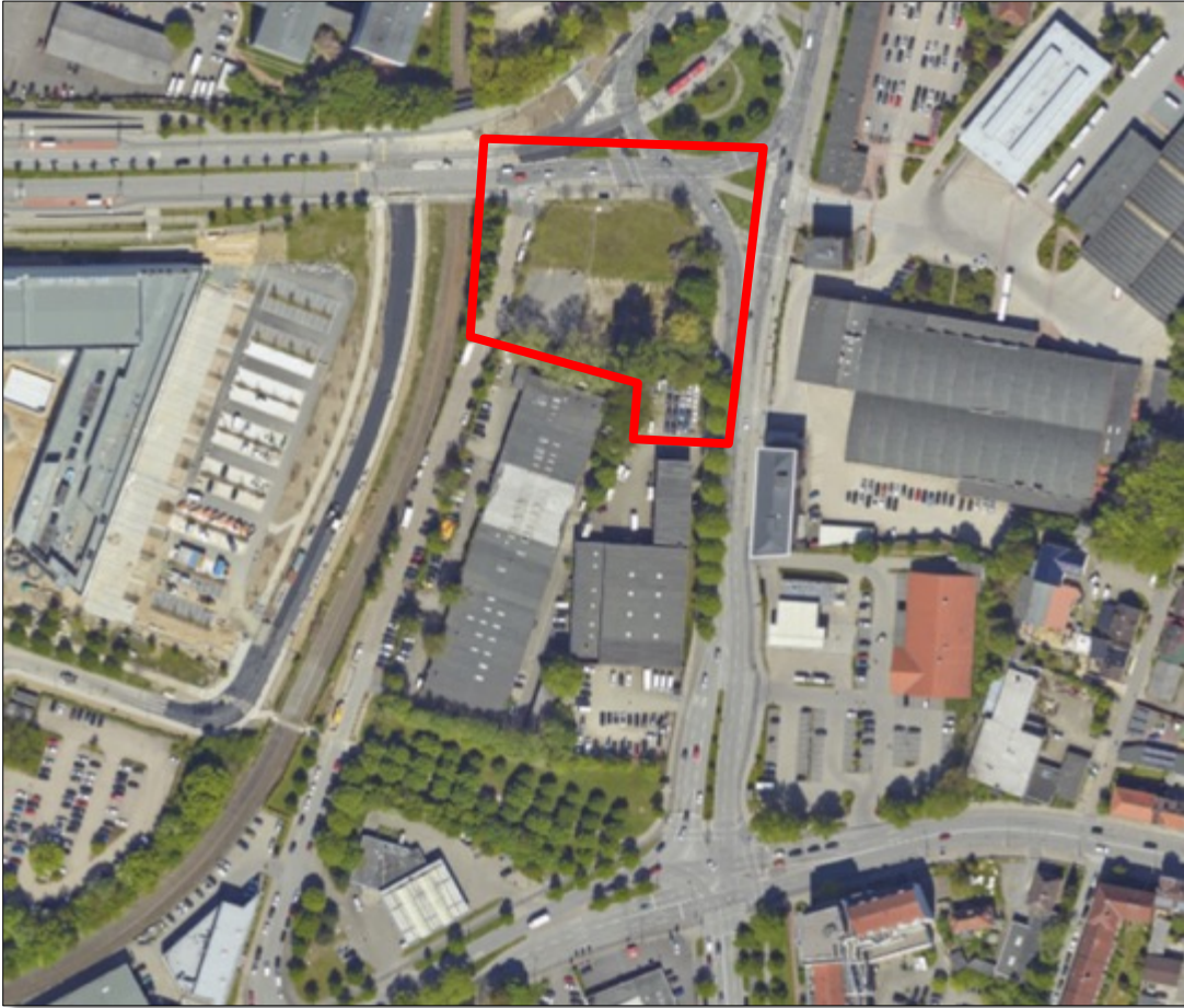
Abbildung 14: Bestandssituation des Plangebietes mit Umgebung (Luftbild LHK)
